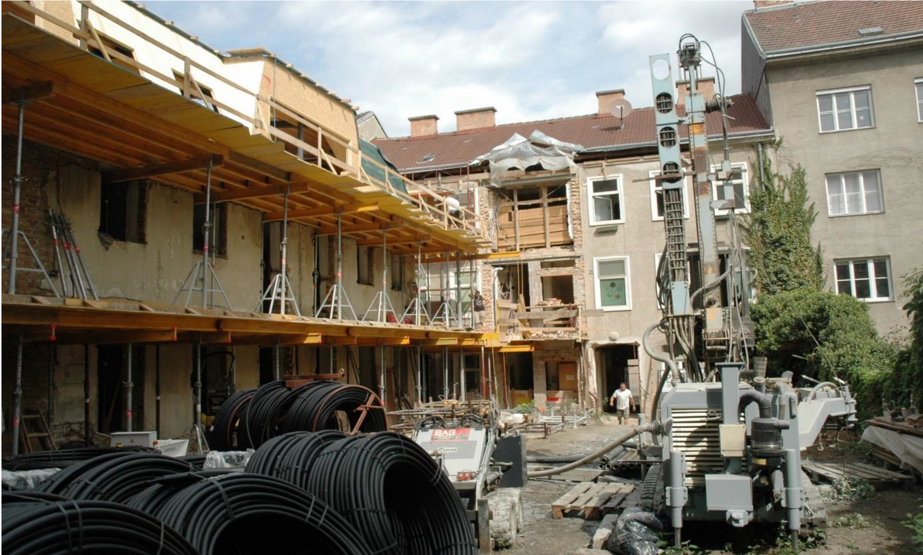
Umsetzung Tiefenbohrungen
