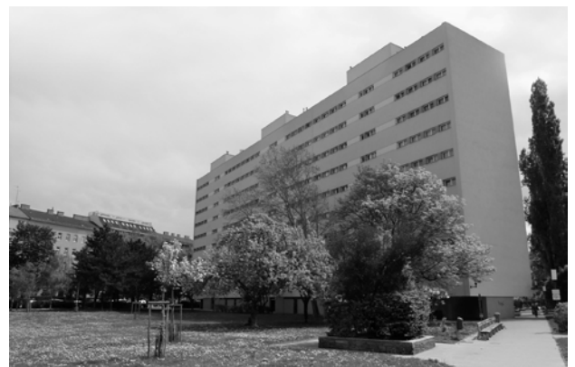
Vorgartenstraße 158–170, 1020 Wien © Karin Standler
