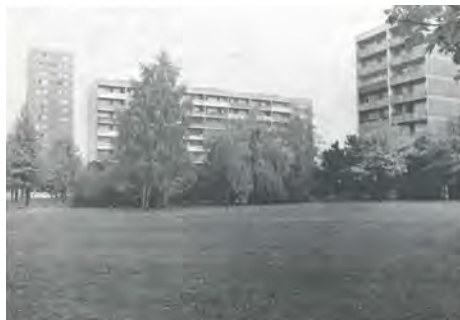
1010 Wien Zeilenbau Eisenstadtplatz Baujahr: 1960
