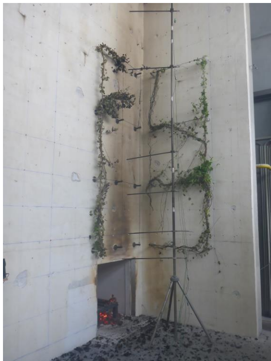
Abbildung 7-16: Fassadenbegrünung zum Ende der Prüfung
