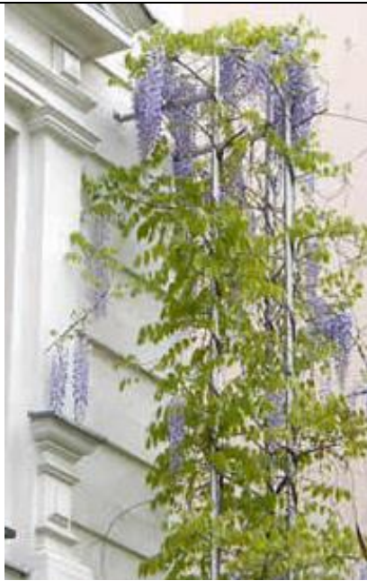
Abbildung 5-2: bodengebundene Fassadenbegrünung mit linearer Kletterhilfe
