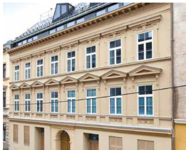
Die Gebäudefront des ehemaligen Vorstadthauses nach der preisgekrönten Sanierung
