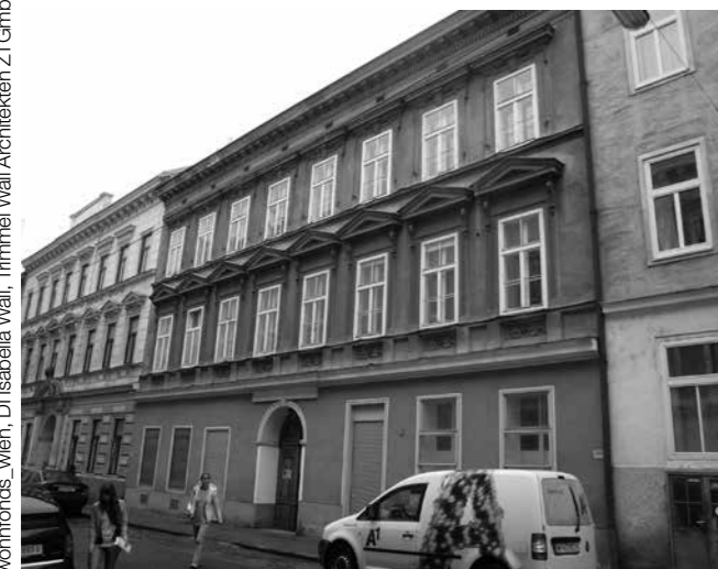
Die Straßenfassade des Gebäudes in der Dingelstedtgasse 12 vor der Sanierung
