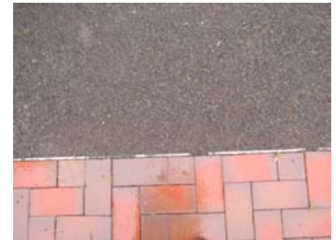
Abb. 4.46: Hannover, Südstadt, deutliche Trennung
