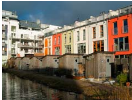
Abb. 3.50: Malmö, Västra Hammen Bo01, Westhafen, Privatgärten, Balkone, Dachterrassen zugänglich und nutzbar für die AnwohnerInnen
