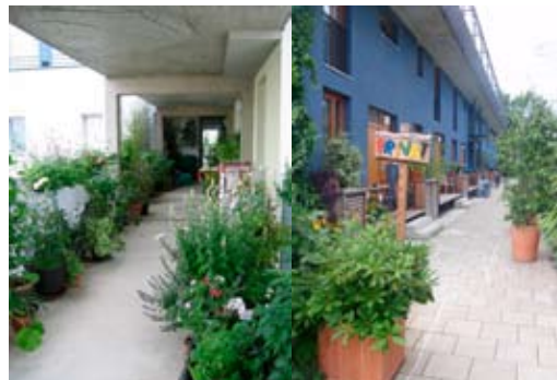
Abb. 3.52: Wien, Autofreie Mustersiedlung, Laubengang zu den Hauseingängen
