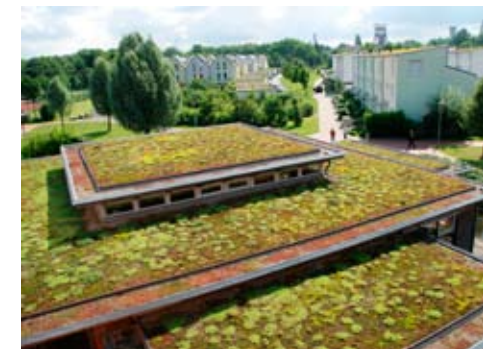
Abb. 4.11: Gelsenkirchen, Solarsiedlung Bismark, Dachbegrünung, Foto: Volkmarm Pamer
