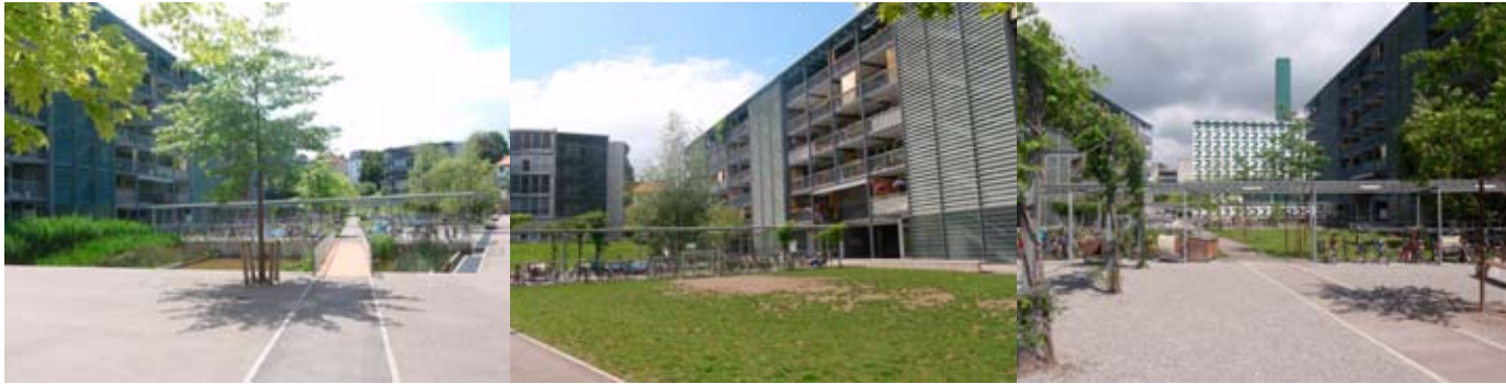
Abb. 3.1 - 3.3: Zürich, Oerlikon, Regina Kägl Hof, Übersicht, vielfältig nutzbare Räume im Hof
