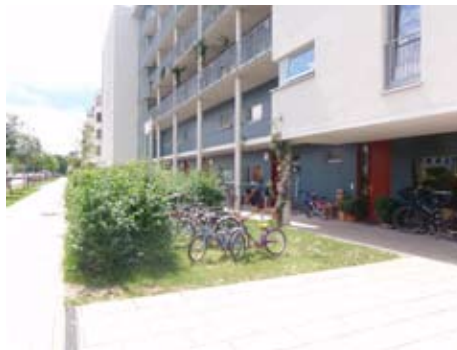
Abb. 3.95: München, Ackermannbogen, Eingangsbereich mit viel Raum und Abstellfläche und Abgrenzung zur Straße
