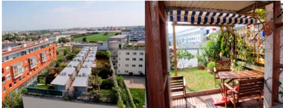
Abb. 3.86 – 3.87: Wien, In der Wiesen Nord, Dachgärten
