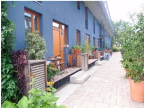
Abb. 4.42: München, Ackermannbogen, Eingangszone
