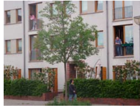
Abb. 2.3: Berlin, Karow Nord, Kommunikation zwischen Wohnung und Straße
