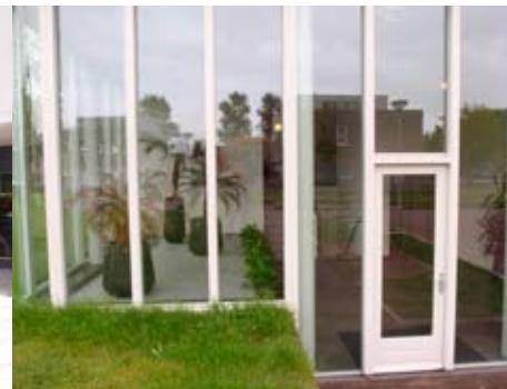
Abb. 3.96: Amsterdam, Osdorp, großzügiger gut einsehbarer Eingangsbereich
