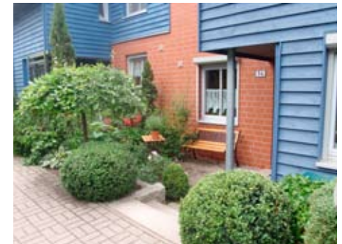
Abb. 4.40: Hannover, Kronsberg, abgesenkter Eingangsbereich
