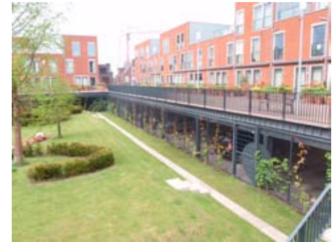
Abb. 4.13: Woerden, Siedlung Carré, Tiefgarage
