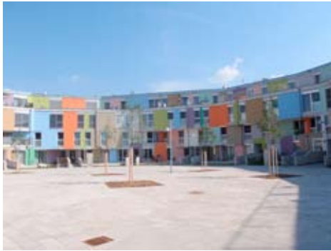
Abb. 4.32: Wien, Orasteig, Wendehammer mit Betonplatten
