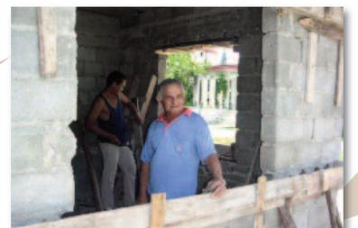
(als Bindemittel für viele verschiedene Baumaterialien) aus Asche, die als Nebenprodukt bei der Verbrennung von Zuckerrohrabfällen entsteht. Mit diesen Abfällen werden ursprünglich die Brennöfen für Tonziegel und Kalksandsteine, die ebenfalls lokal hergestellt werden können, beheizt.
