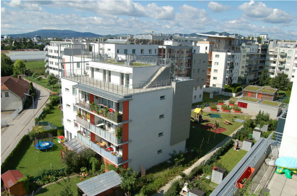
Abbildung 24: Blick von der Dachterrasse in den Innenbereich der Anlage
