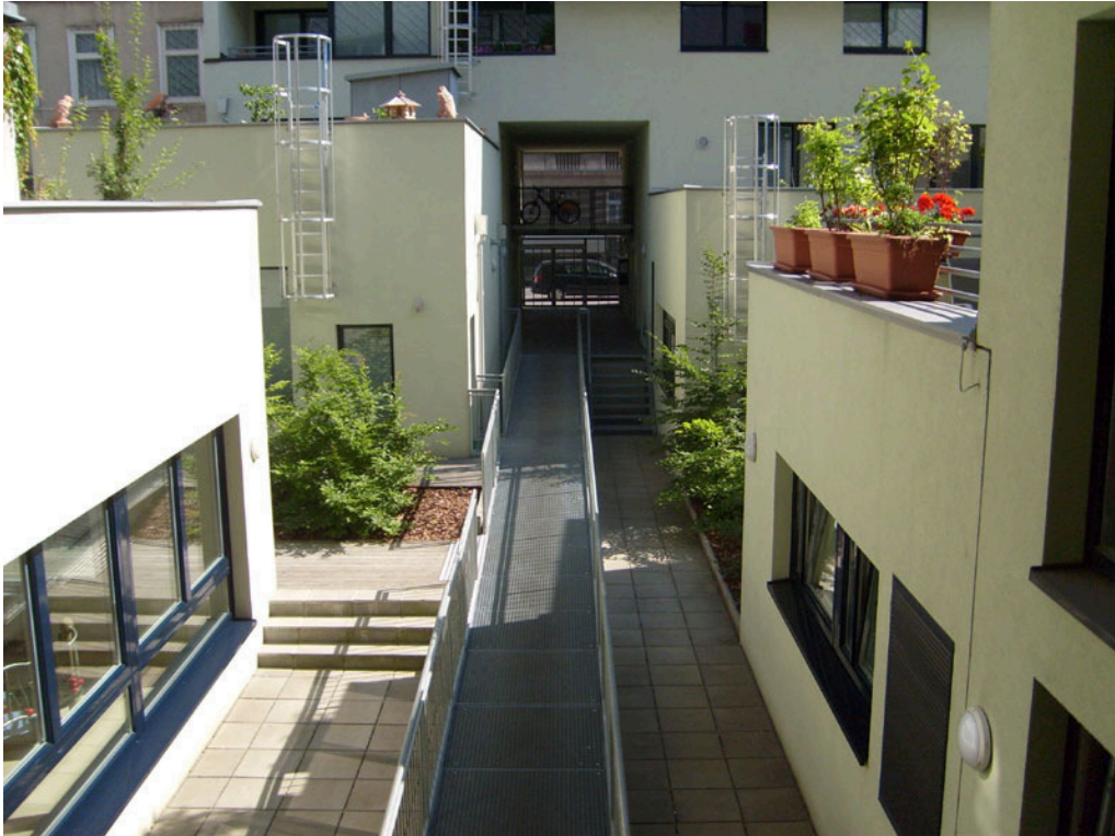
Abbildung 37: Innenhof mit Rampe
