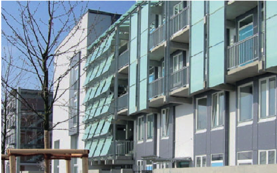
Abbildung 6: Georg-Kerschensteiner-Straße 4-10 / Maria-Montessori-Straße 9-15, München; Reine Baukosten: 1.184,- Euro/m 2
