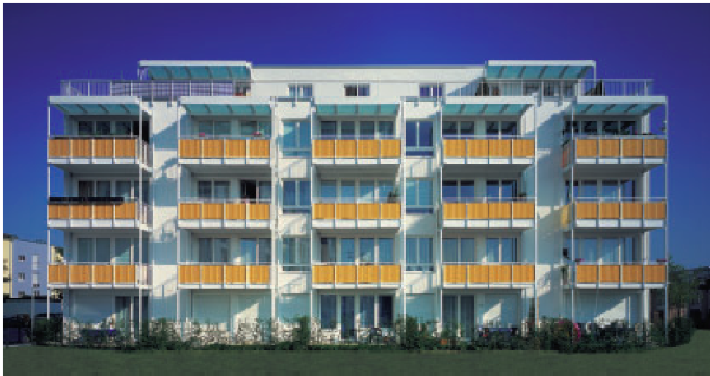
Abbildung 5: Niedrigenergiehaus Felicitas-Füss-Straße 15, München; Reine Baukosten: 1.180,- Euro/m 2
